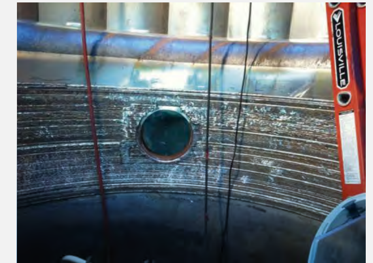
• Auto-MIG Bore Weld
